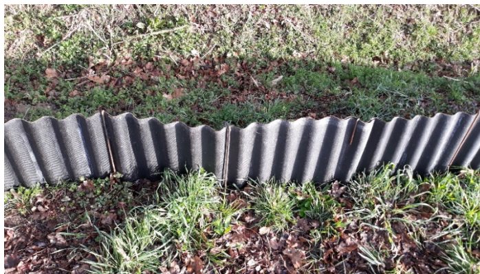
Slika 27. Niska ogradica koja sprečava izlazak vodozemaca na prometnicu (osobni arhiv, fotografirano 7. 3. 2020.)
