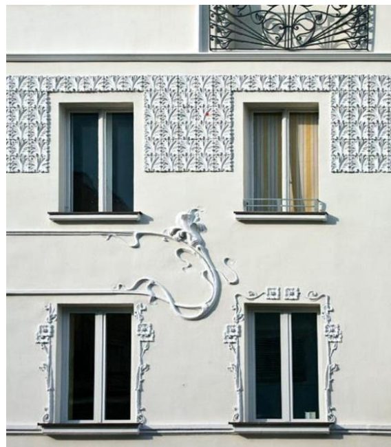
Slika 19. Kuća Schittar , Emilio Ambrosini
